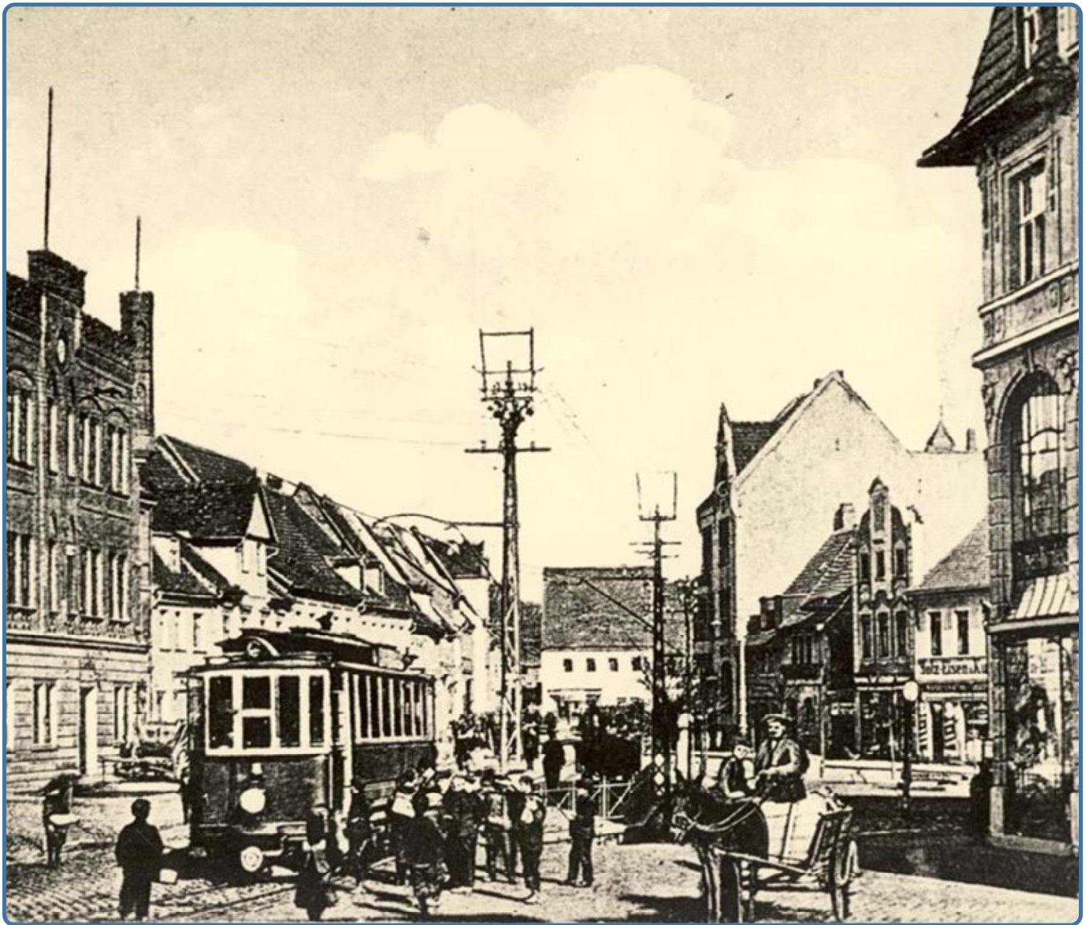
Hettstedt: Ein Kleinbahntriebwagen auf dem Markt. Auf den Mastspitzen die technischen Einrichtungen zur Elektroenergieversorgung von Fremdkunden.
